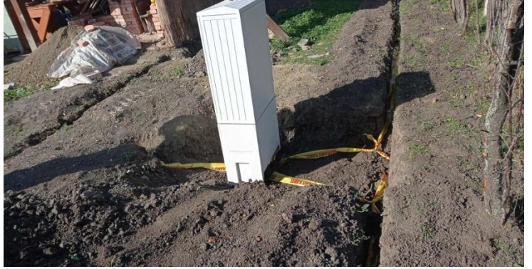
Villamos hálózat kiépítése
